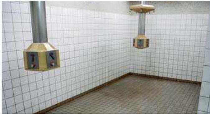
Carrelage au sol et aux murs fixé avec de la colle amiantée
