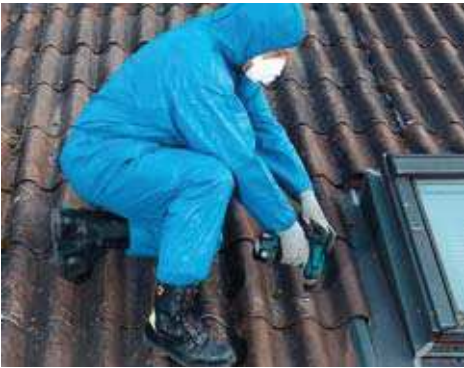
Remplacement de fenêtres de toit
