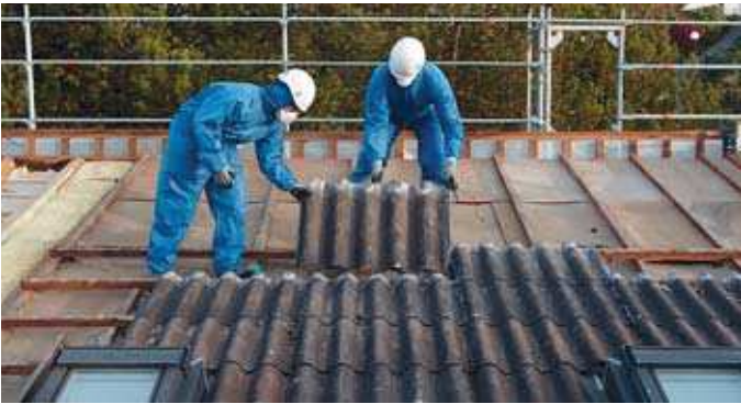
Démantèlement de plaques ondulées
