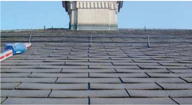
Toit en ardoises
