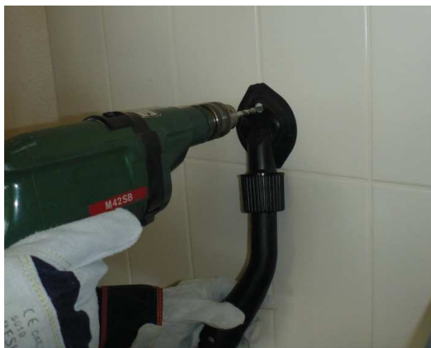
4 Perceuse avec aspiration intégrée pour les carreaux en céramique comportant de la colle amiantée.
