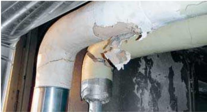
Tuyau avec mortier amianté
