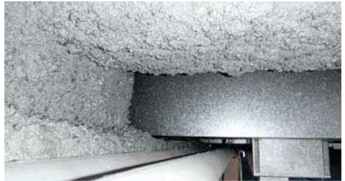
Amiante floqué utilisé comme protection incendie sur une poutre métallique
