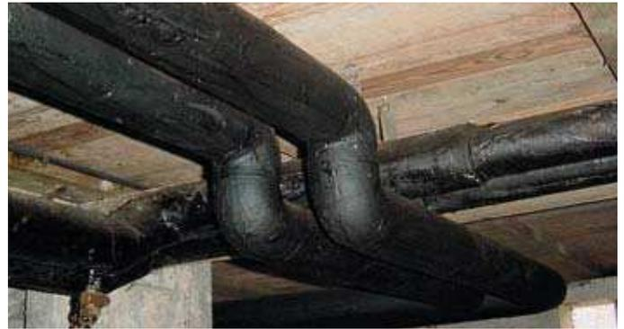
Tuyau avec revêtement bitumineux amianté
