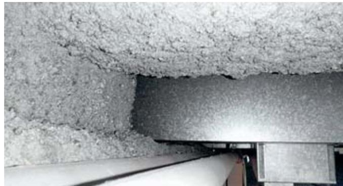
Amiante floqué comme protection incendie sur une poutre métallique
