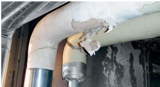
Tuyau avec mortier amianté
