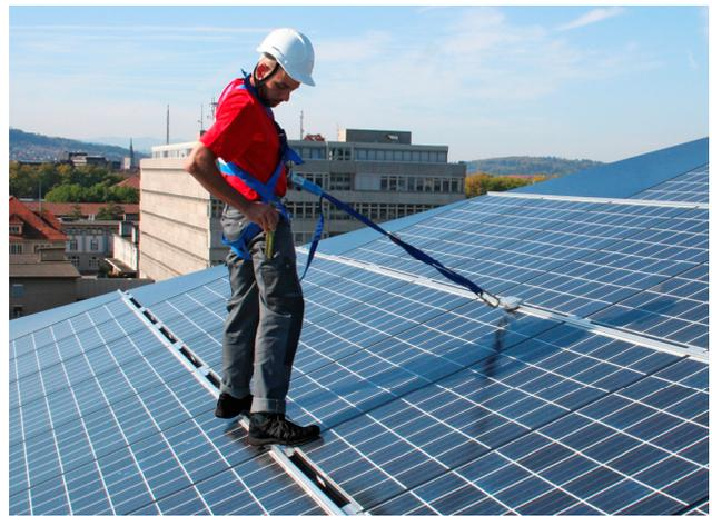
3 Installation photovoltaïque avec protection contre les chutes pour l'entretien et la maintenance (à utiliser comme système de retenue).
