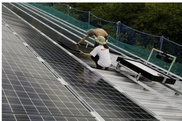
2 Les collecteurs doivent être montés uniquement avec une protection collective (paroi de retenue, échafaudage avec pont de ferblantier, etc.).
