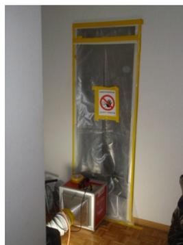
5 Zone d'assainissement confinée avec appareil de sous-pression
