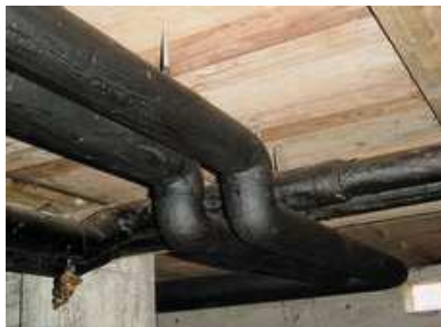
2 Isolation de tuyau avec revêtement bitumeux amianté.
