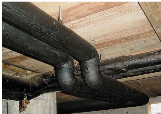
1 Ce revêtement bitumeux amianté se découpe et s'enlève facilement au cutter.
