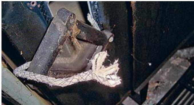
Cordon amianté servant de joint d'étanchéité pour une installation
