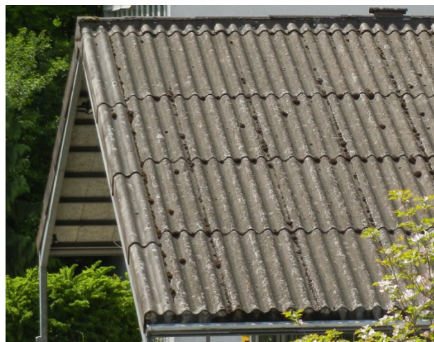
1 Plaques ondulées en fibrociment amianté
