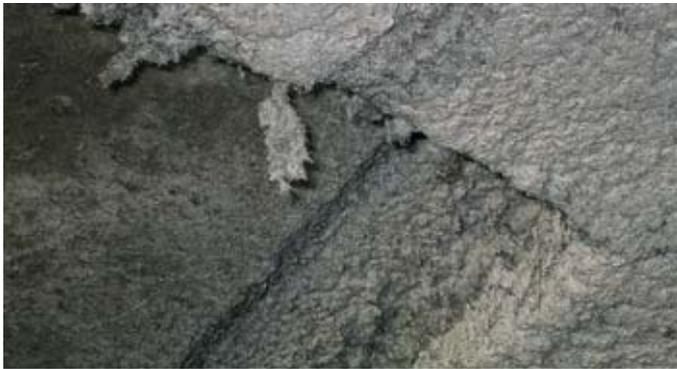
Amiante floqué sur une poutre métallique
