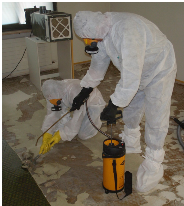
6 Méthode d'enlèvement des revêtements.
